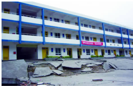
(d) 断层边规范建造的砖混结构教学楼未倒塌(白鹿学校)
