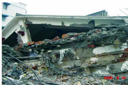
图 13 混凝土框架倒塌后楼盖叠压的情况 (薛延涛提供)
