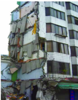
图 19 冷轧带肋钢筋圆孔板断裂(汉旺镇)
