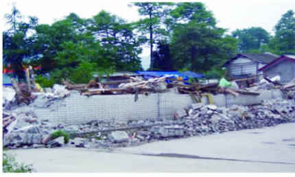
(a) 砖-木结构平房倒塌(通济学校)
